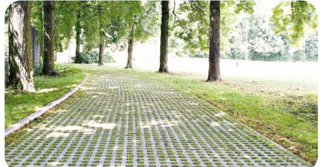
Revêtement de circulation douce semi-perméable
